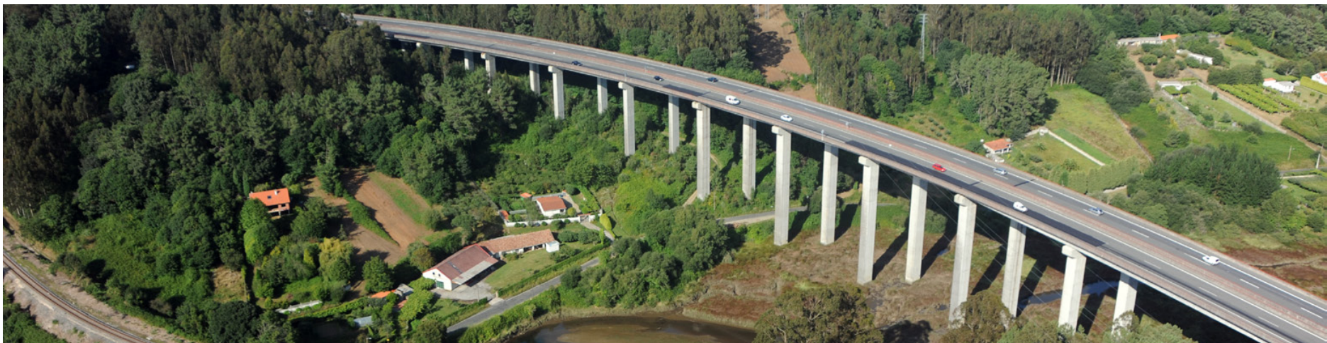
Viaducto e trazado ferroviario. Rías Altas
