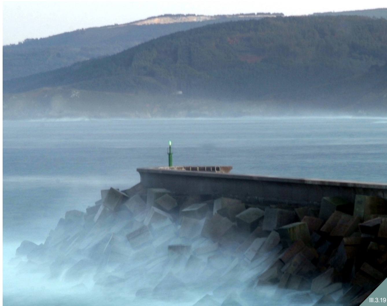
Caión. Arco Bergantiñán
