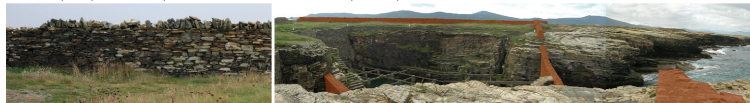
O mesmo sistema de protección: o muro.
