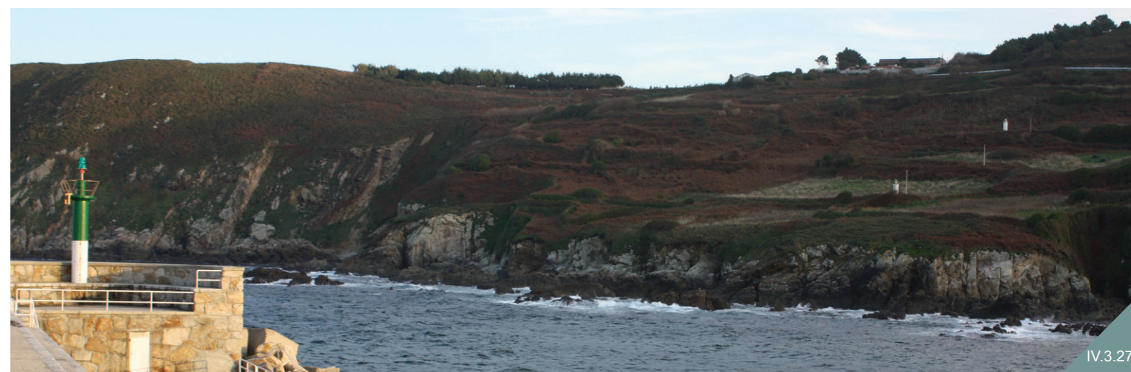
IV.3.27 Faro de entrada a porto e as balizas de enfilación
