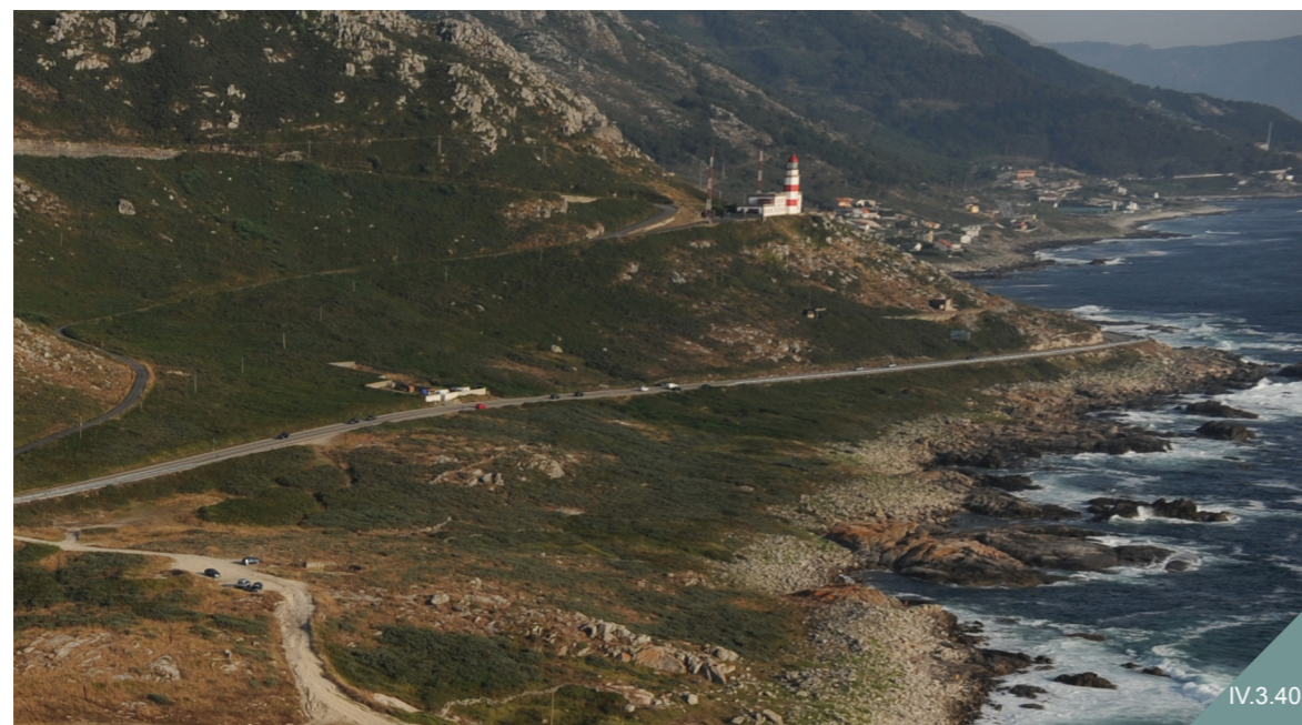
Faro de Cabo Silleiro
