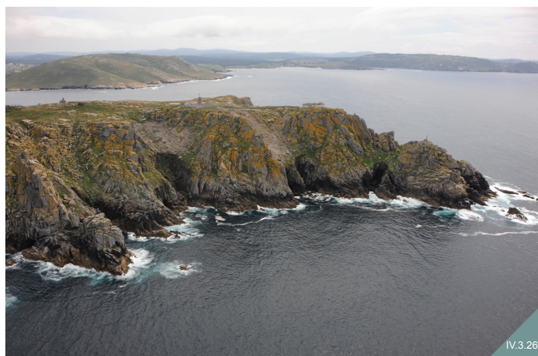
IV.3.26 Faro de las Illas Sisargas
