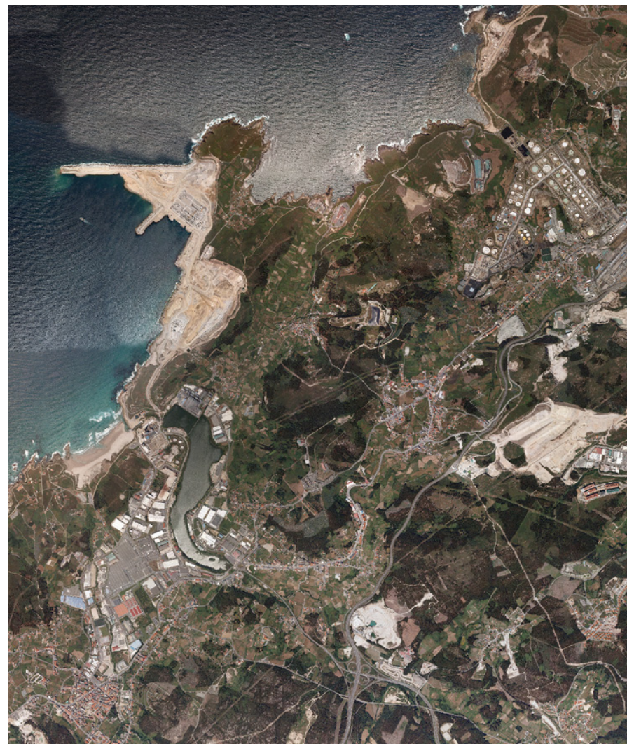
Puerto Exterior de A Coruña y su entorno industrial y empresarial. Ortofoto PNOA 2008
