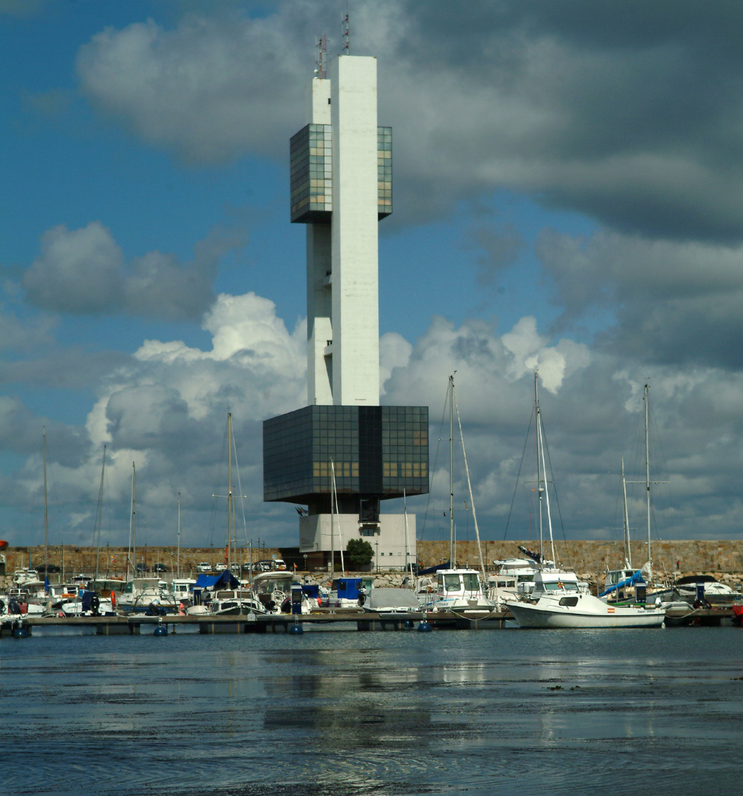
Torre de control marítimo. A Coruña
